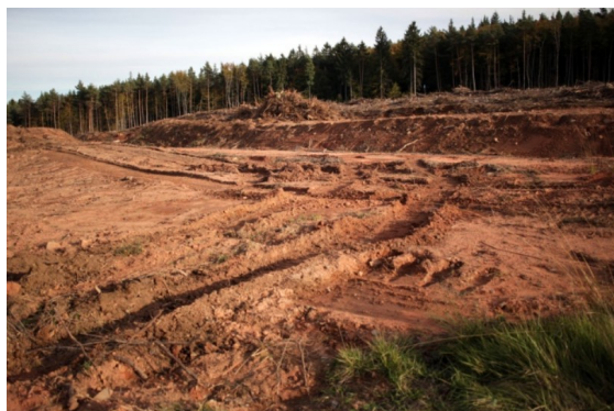
Erdarbeiten am Rande eines Wasserschutzgebietes (Foto: Matt Millham, S & S)
