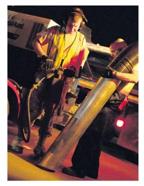
Risse in der Startbahn werden mit einem Presslufthammer aufgeweitet, damit sie anschließend ausgegossen werden können. Die Betonbrocken saugt ein Riesenstaubsauger auf.
