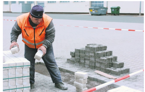
Das weiße Landekreuz wird verlegt. (Foto: Sgt. Frank Sanchez III)
