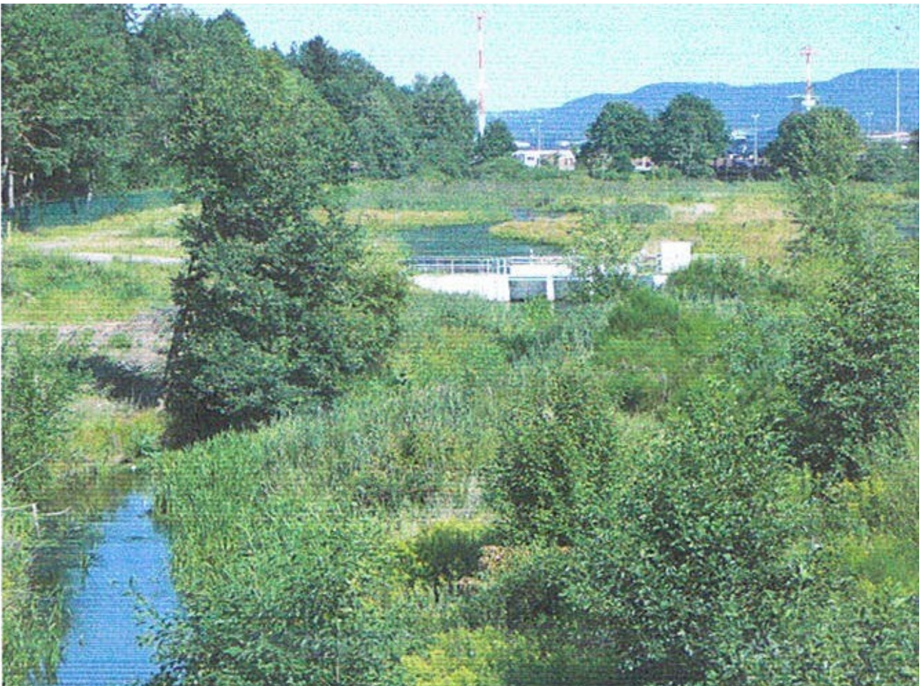
Zweites Absetzbecken außerhalb des Air Base-Zaunes mit abfließendem Mohrbach
